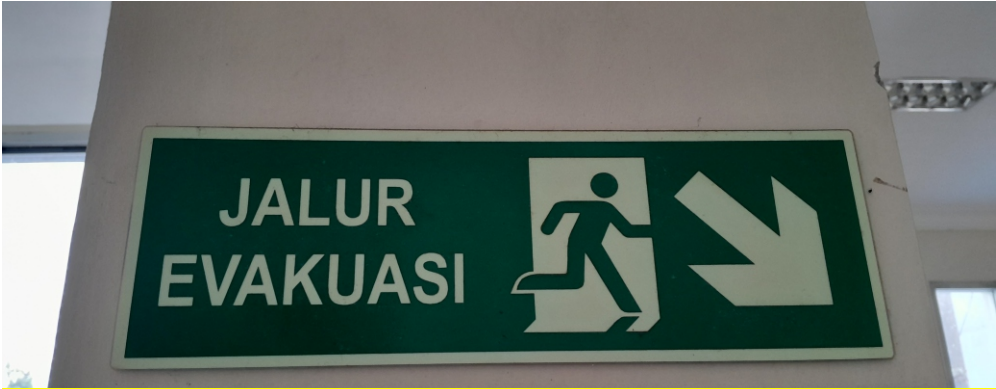
Inspeksi Jalur Evakuasi
